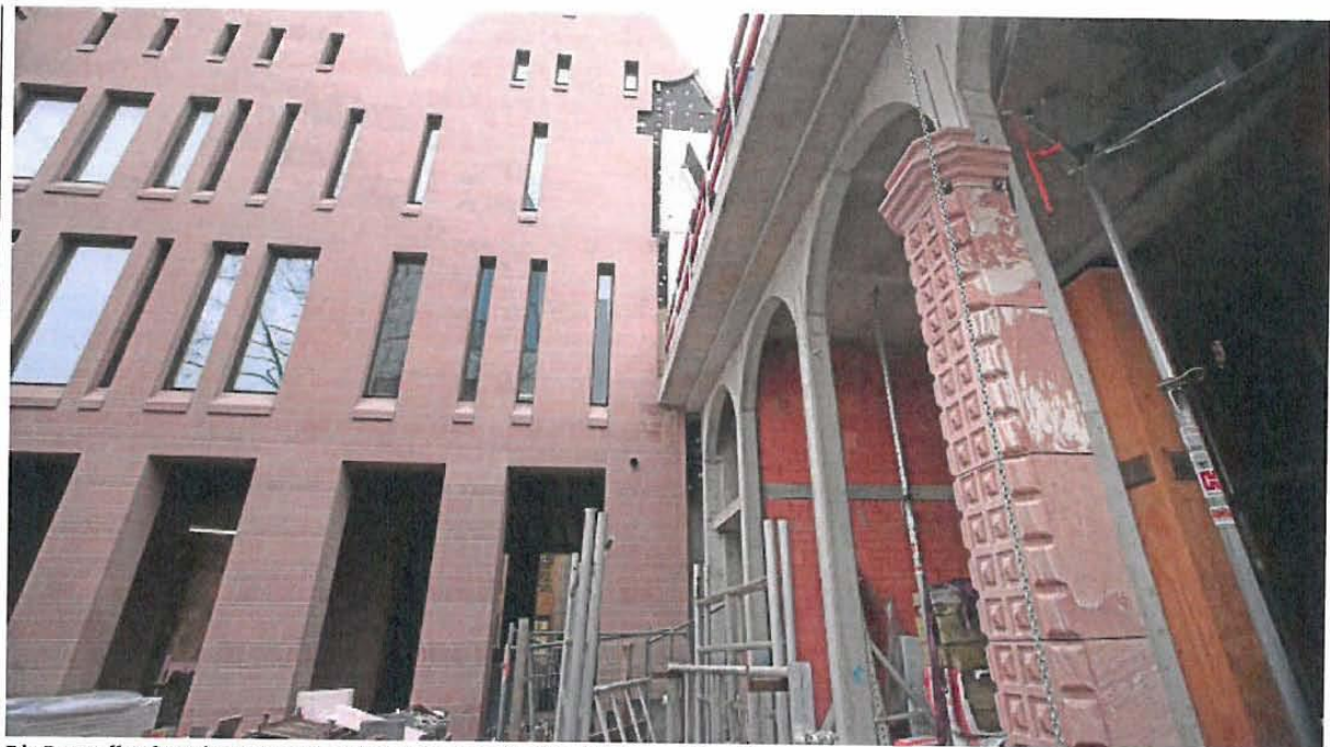
Die Baustelle Altstadt, rechts die ersten Fassadenteile der „Goldenen Waage“.
