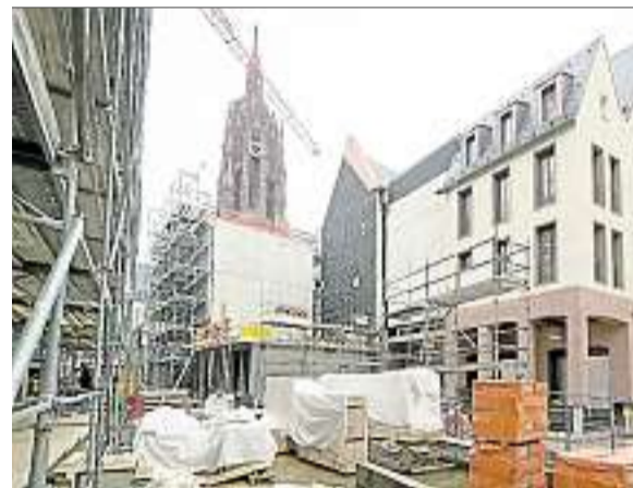
Vor dem Dom wächst langsam die Altstadt. Von der Braubachstraße ist das gut zu beobachten.
