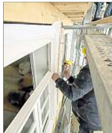
Am Haus „Zur Flechte“ am Hühnermarkt werden Fenster eingesetzt.
