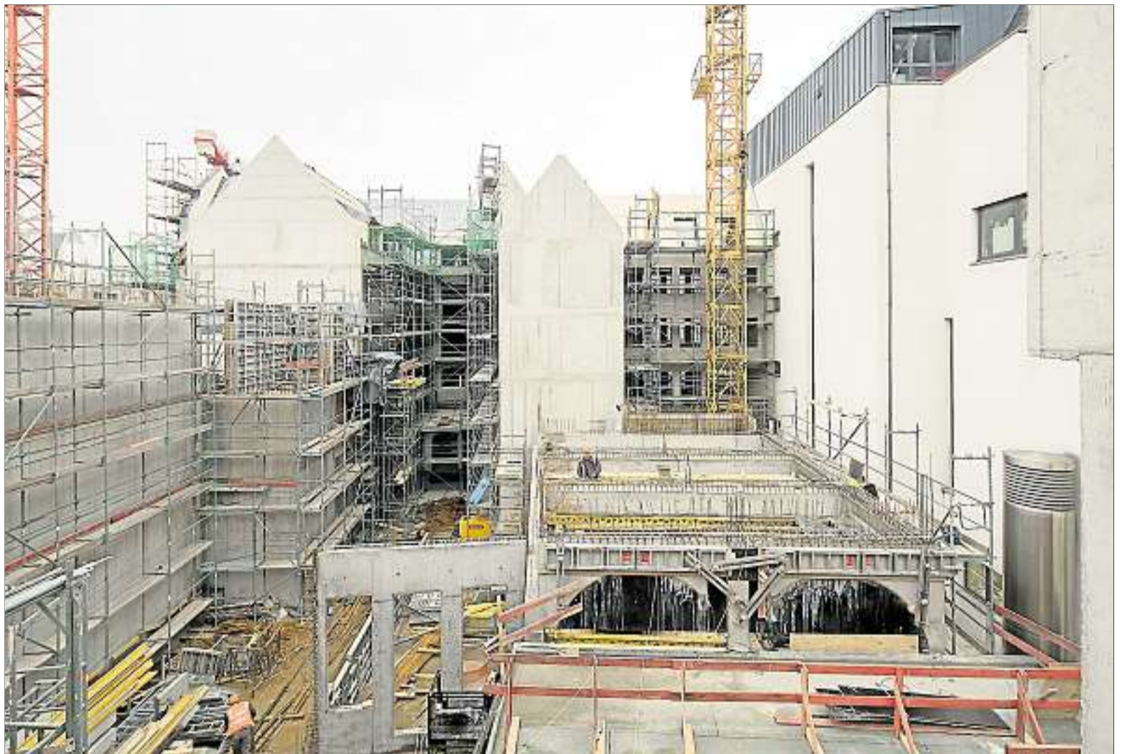
Blick von der Braubachstraße in die neu entstehende Altstadt.
